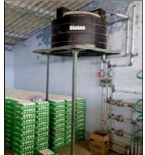
Figure 12. Bac d'eau à l'intérieur du bâtiment permet de garder une eau plus fraîche.
