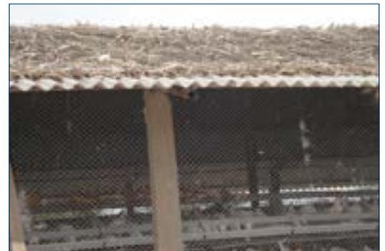
Figure 8. Utilisation de matériaux de paillage (paille de riz, rafles de maïs, fanes de canne à sucre) pour réduire le réchauffement solaire du toit.
